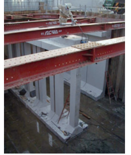
Şek. 4 şantiyedeki birleştirme yöntemini göstermektedir. I şekilli elemanlar, ön gerilim teknolojisiyle birleştirilmektedir ve böylece deprem güvenliğini sağlarlar.
