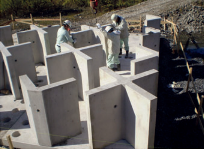
Şekiller 5 ve 6: X şekilli yağmur suyu deposunun montajı
